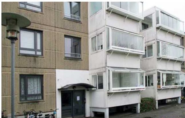
Eksisterende forhold med de karakteristiske altaner
