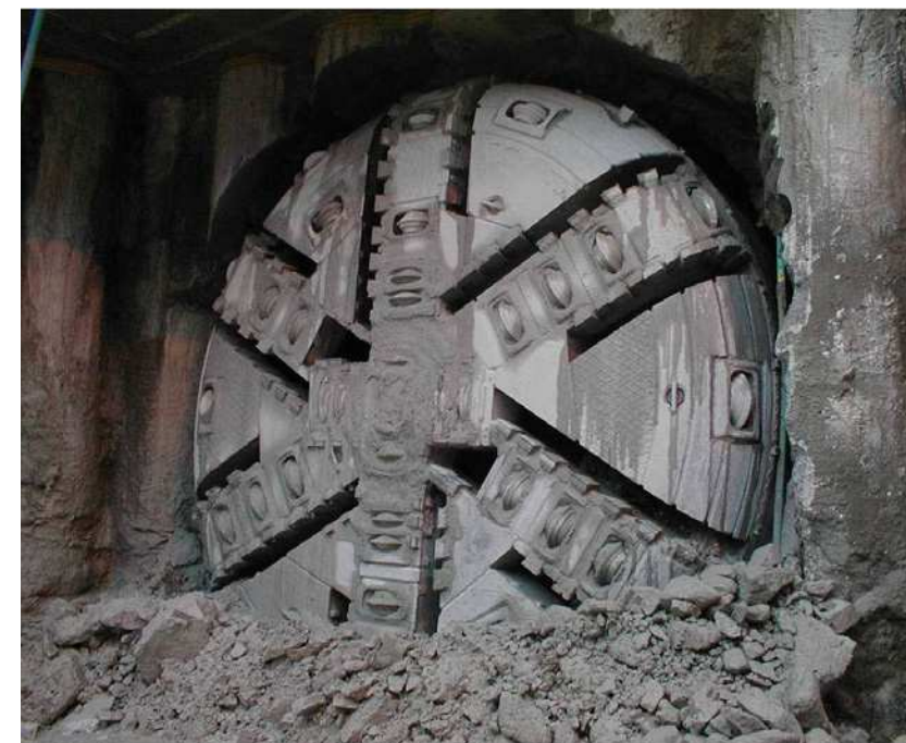
Figur 4.60 Frontskjoldet på en tunnelboremaskine efter gennembrud til en station eller skakt.
