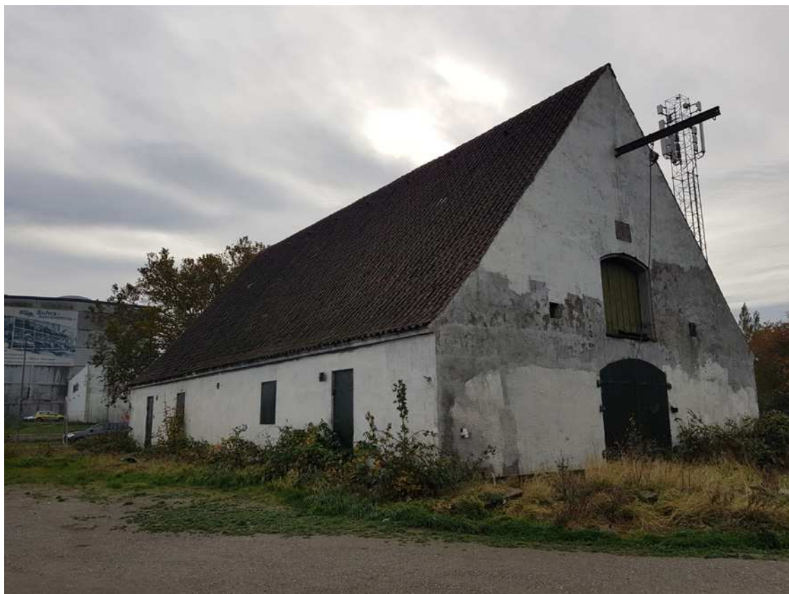
Figur 17.4 Den fredede bygning 'Krudthuset' ved Prags Boulevard.
