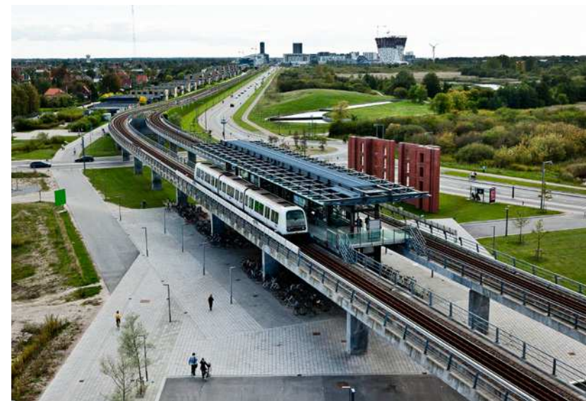
Figur 4.35 Eksempel på højbanestation på M1 ved DR Byen.
