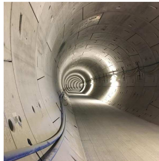
Figur 4.57 Tunnelrør beklædt med præfabrikerede betonelementer. Eksempel fra Nordhavnsmetro.
