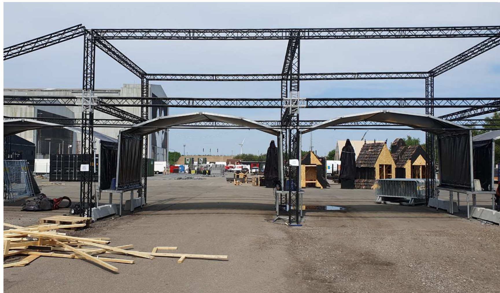
Figur 10.15 Refshaleøen – nedtagning af indgang og scener fra COPENHELL pågår, juni 2023.
