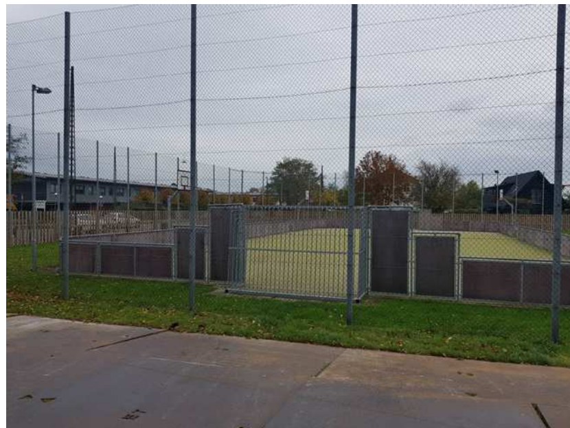
Figur 10.2 Boldbane bag Grønjordsskollegiet ved Røde Mellemvej. COWI foto november 2023.
