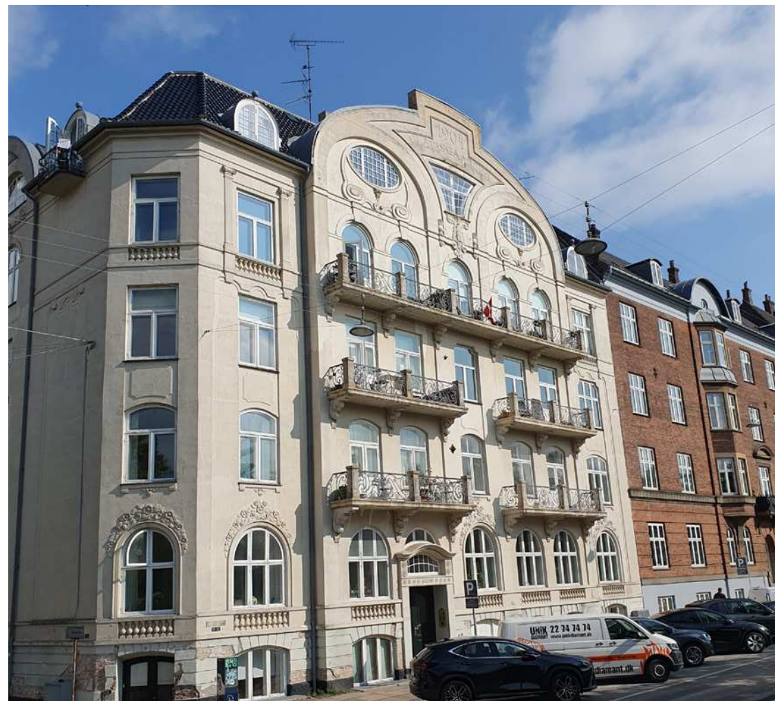
Figur 17.3 Fredet bygning i jugendstil Østbanegade 11.
