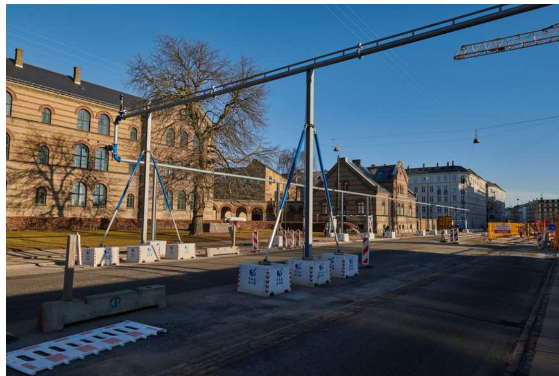
Figur 13.14 Eksempel på ledningsnet til reinfilerationsboringer.
