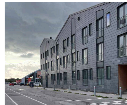
Hård overgang og ingen kantzone mellem kollegie og vej.
