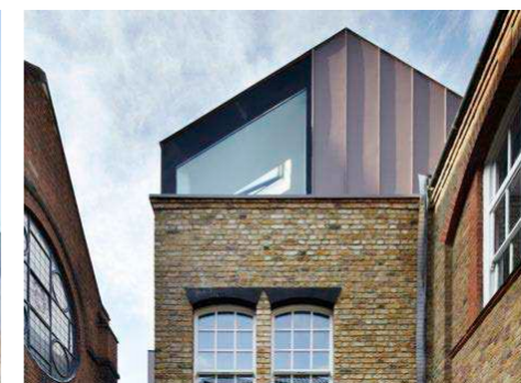
Transformation af omklædningsbygningen
