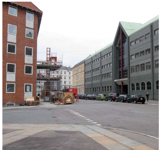
Skt. Kjelds Kvarter Syd er karakteriseret ved forskelligartede arkitektoniske udtryk
