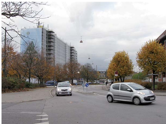
Kollektivhuset ved Hans Knudsens Plads
