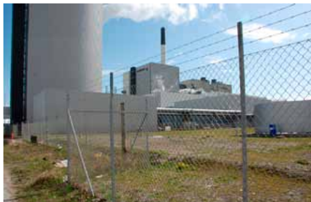
Amagerværket set fra Vindmøllevvej.
