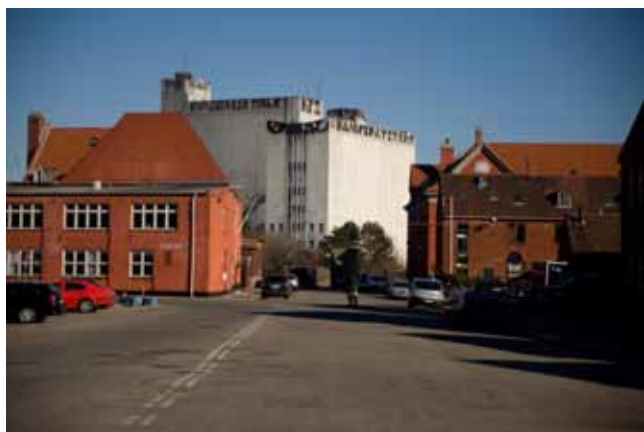
Siloernes skulpturelle helhed og komposition er en vigtig del af Århusgadekvarterets egenart og bebyggelsesstruktur
