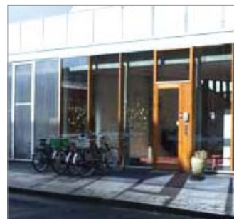
Åbne facaden mod Sigurdsgade
