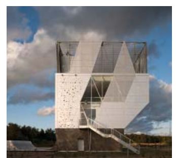
Sportsfunktioner integreret i den ydre facade
