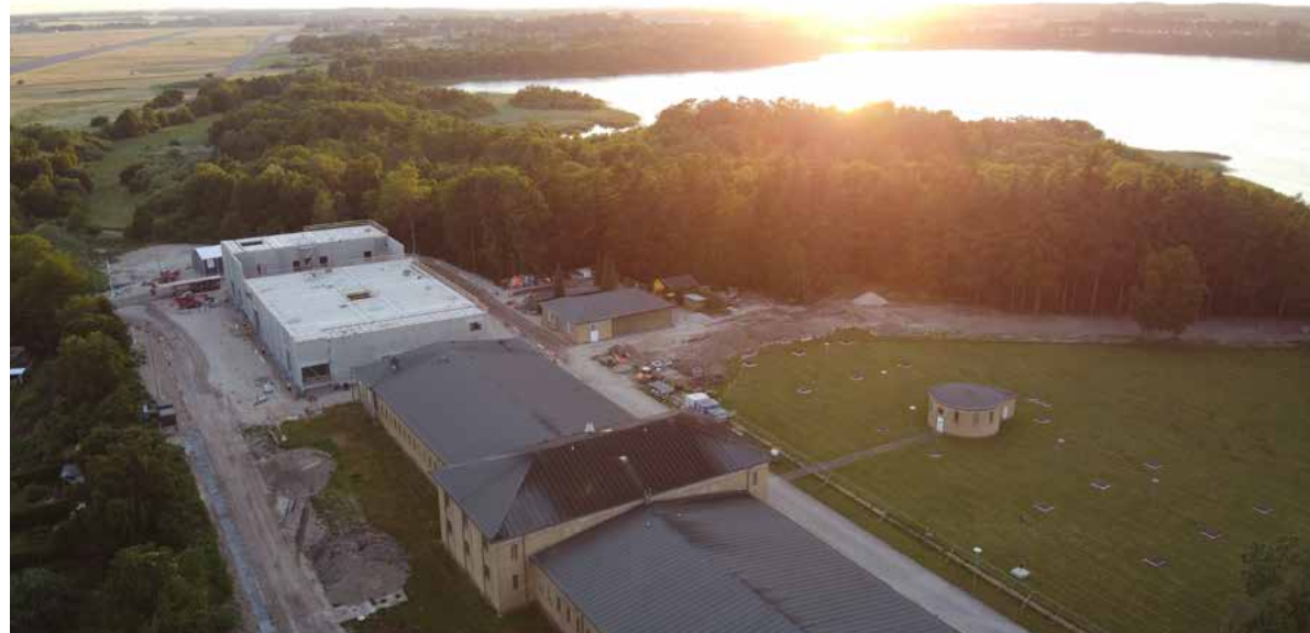
Værket ved Sønderø gennemgår en stor ombygning og renovering. Bygningsarbejdet følger tidsplan, således at værket kan være med til at levere blødere vand til kunderne.
