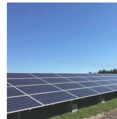
HOFORs solcellepark ved Kikkenborg syd for Lemvig.
