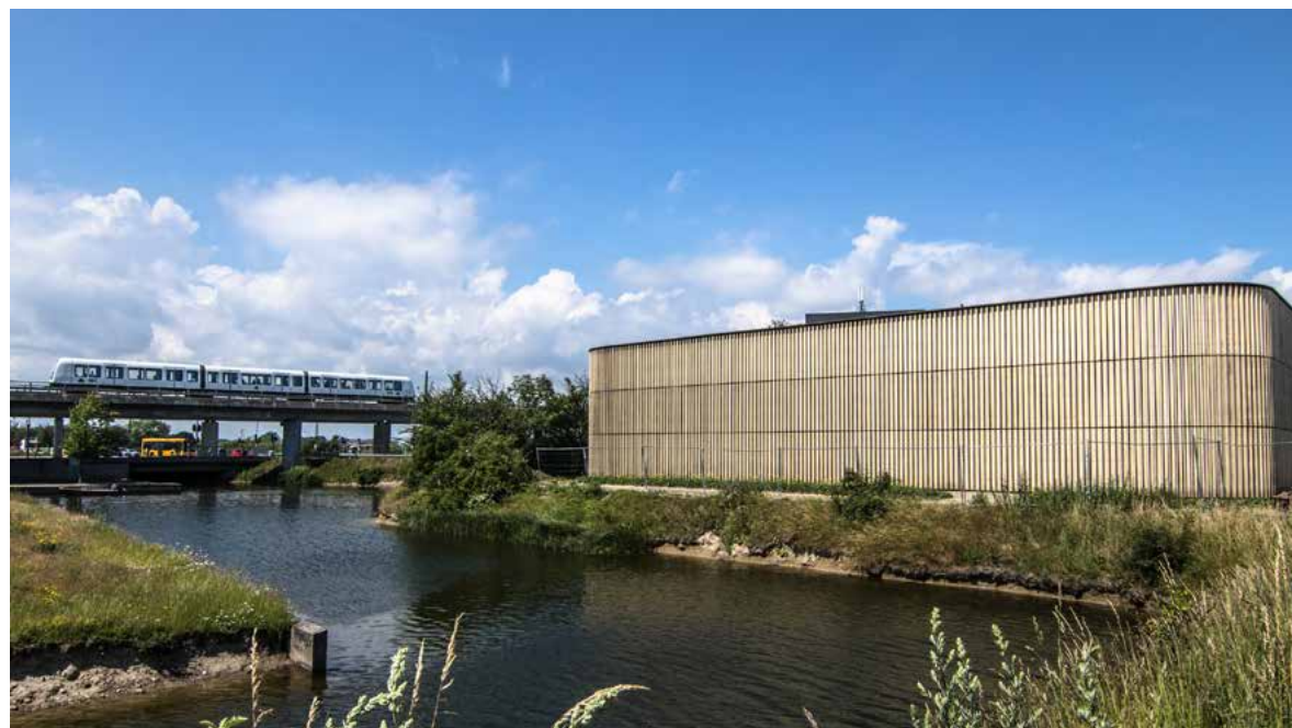
Fjernkølingscentral i Ørestaden.
