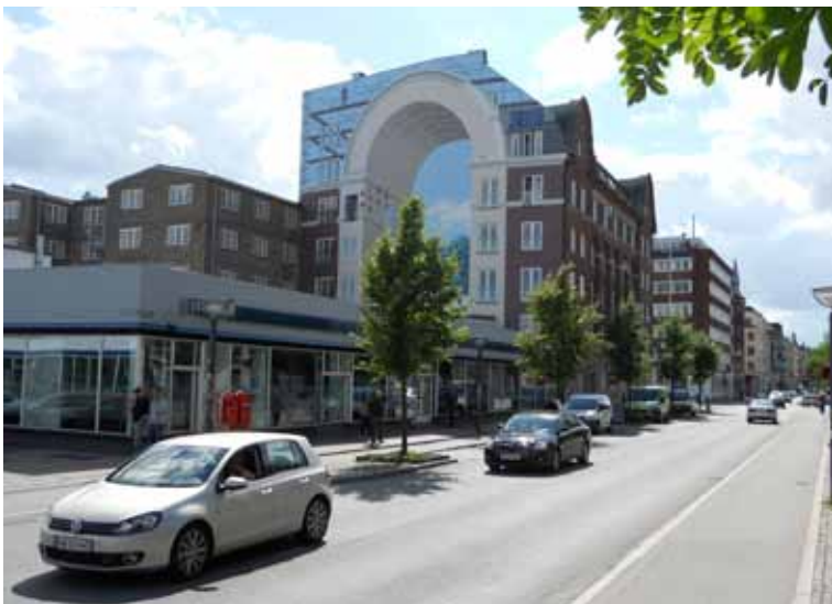
I forgrunden Den Hvide Kødbys randbebyggelse mod Halmtovet. Bagved ses Halmtovet 29 (med gavlmaleri af Peter Abelin), der er ombygget til ejeboliger.
