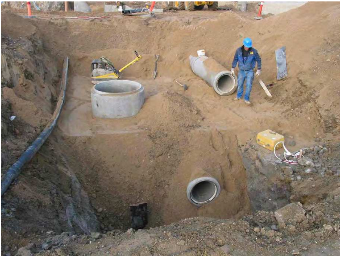
Foto 1 Nykloakering. Der anlægges både spildevandsledning og regnvandsledning
