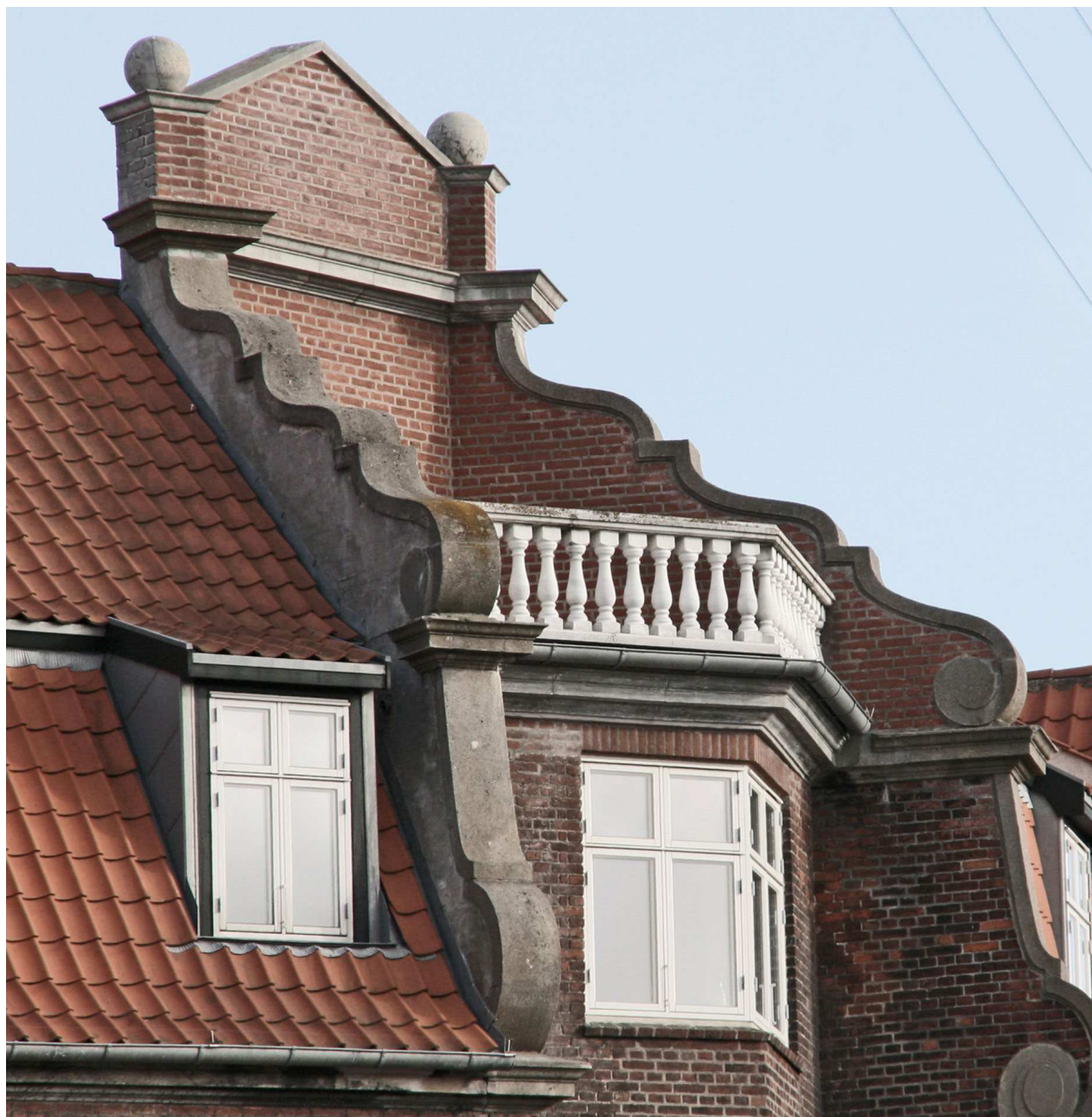
Snorregade. Oprindelig tagterrasse i mansardtag.
