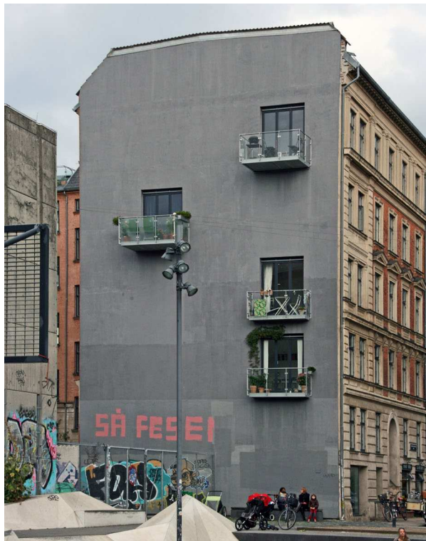
Ahlefeldtsgade. Den forskudte placering og de enkelt udformede altaner med transparente værn skaber liv på facaden samtidig med at de enkelte altaner får mere lys.
