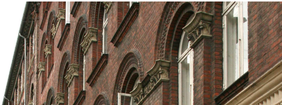
Holbergsgade. Detaljerig muret facade med rundbuer
