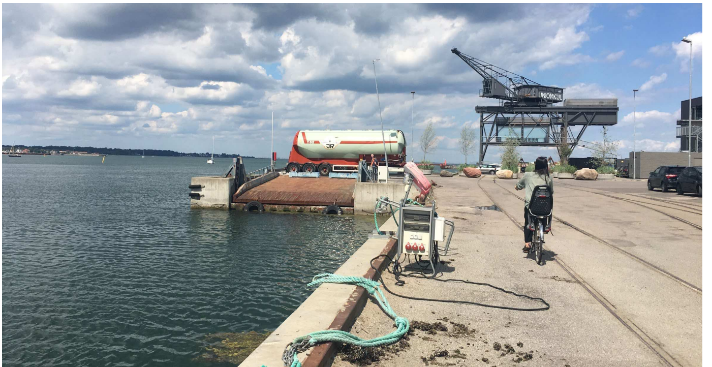
Fortøjningsringe, skinner og betonbolværker på kajen langs med Kalkbrænderiløbet. Midt i billedet ses 'færgestedet' som fremstår med en rampe af jern, og bagerst, uden for lokalplanområdet, den markante 'Unionkul Kran', der i dag bl.a. anvendes til konferencefaciliteter.
