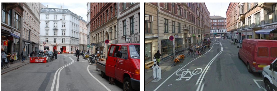
Figur 1. Eksisterende forhold i Elmegade set mod nord (tv) og mod syd. Kørearealet er blevet inddraget til parkering og udeservering.
