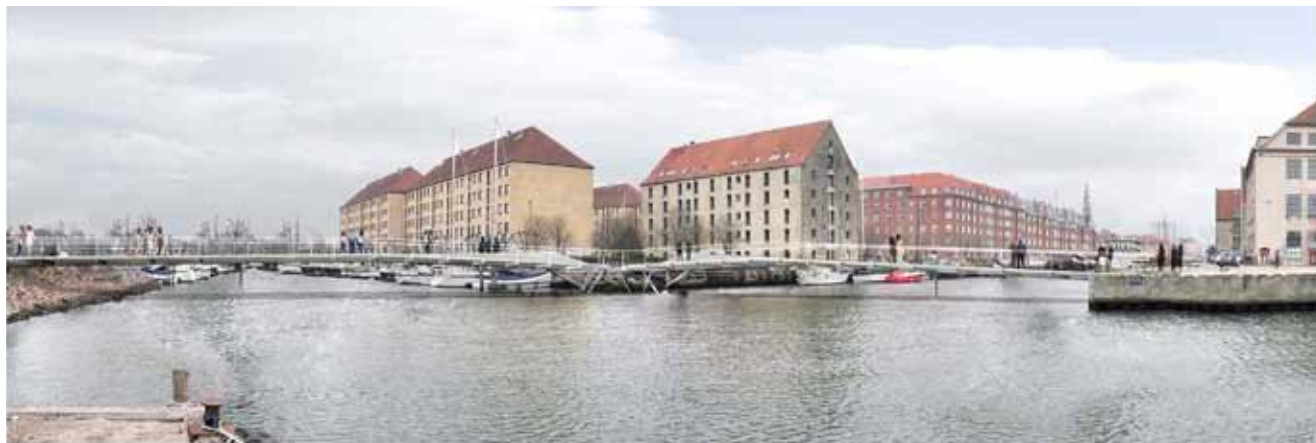
Kanalbro over Trangravnen og Christianshavns Kanal.
