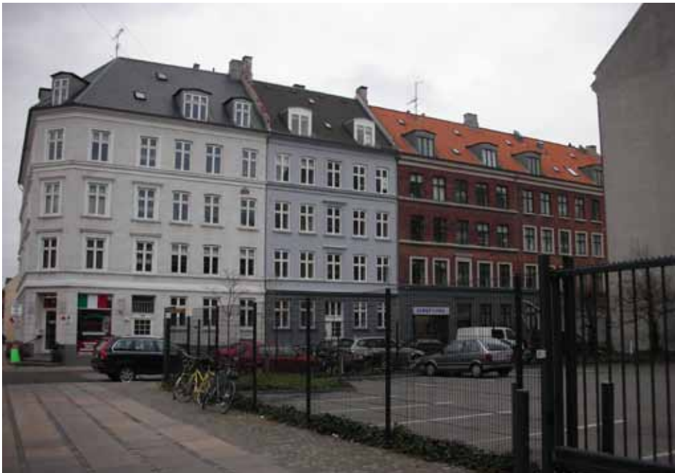
Facader i Fanøgade over for lokalplanområdet.
