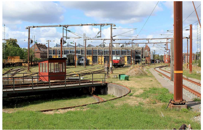
Drejeskiven er et af de bevaringsværdige tekniske anlæg, der er karakteristisk for området.
