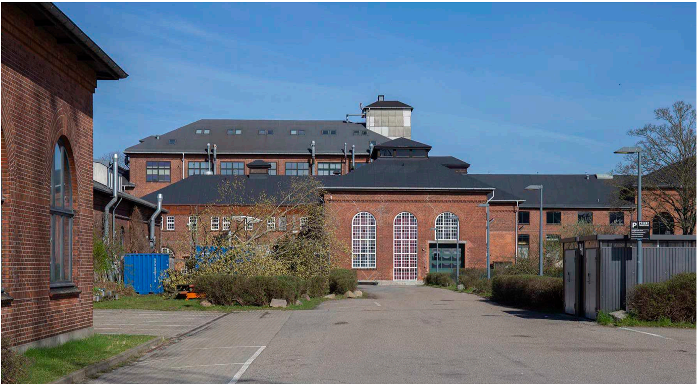
Det indre af Centralværkstederne med bevaringsværdige bygninger. Dette område bliver centrum for det nye kvarter i det nordlige område.
