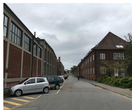
Vejforløb syd for det nye lokomotivværksted.
