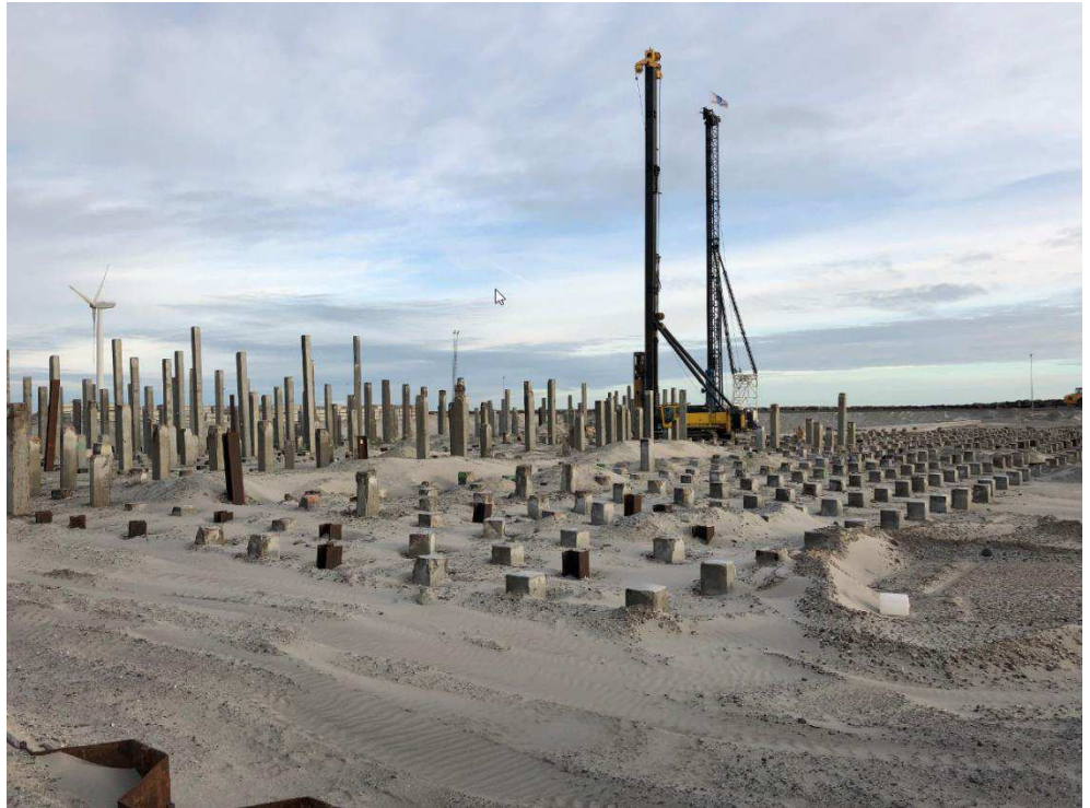
Figur 4-26 Eksempel på anlæg af pælefundering (COWI)
