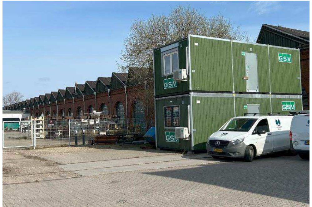
Figur 5-20 Vognværkstedets vestlige facade set fra syd. Foto COWI 2024.
