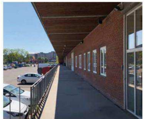
Figur 5-130 Toldkammerets facader er i røde flensborgsten. Fotos Cobe.
