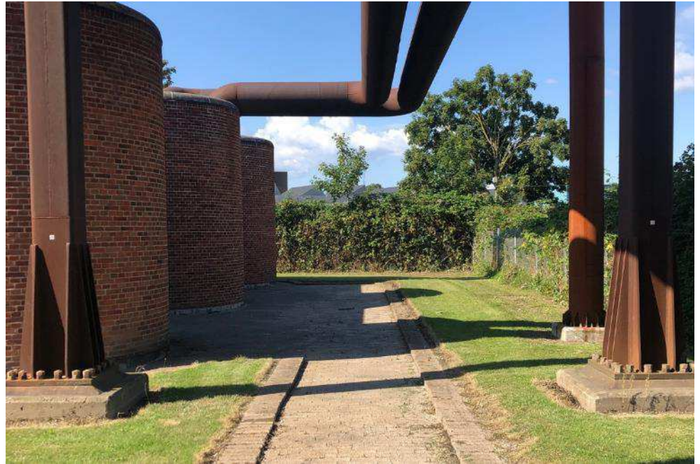
Figur 6-5 Murstensvoluminer og rør mod øst. Foto Cobe.
