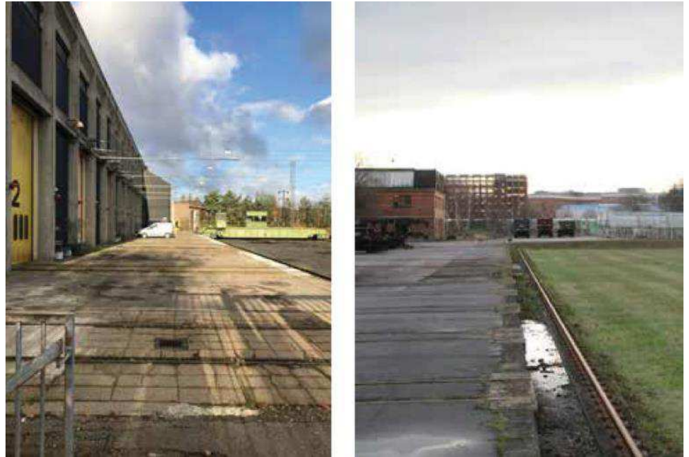
Figur 6-11 Illustrationen viser spor i industrielle anlæg – i sammenhæng med skydebroen og de gule porte på Ny eftersynshal. Foto Cobe.
