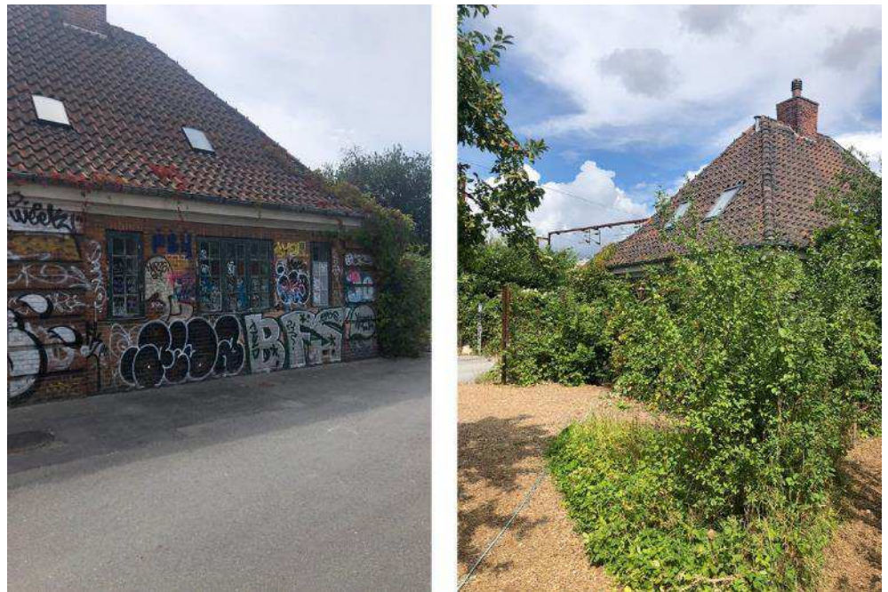
Figur 5-5 Foto th. Portbygning set fra nord for enden af Otto Bussesses Vej. Foto tv. af Portbygningen set fra Bivejen. Foto Cobe 2023.
