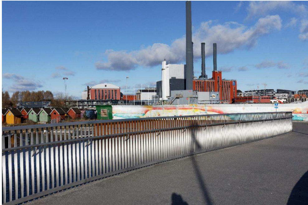
Figur 7-14 Punkt 6 – Alfred Nobels Bro. Eksisterende forhold. (COWI)
