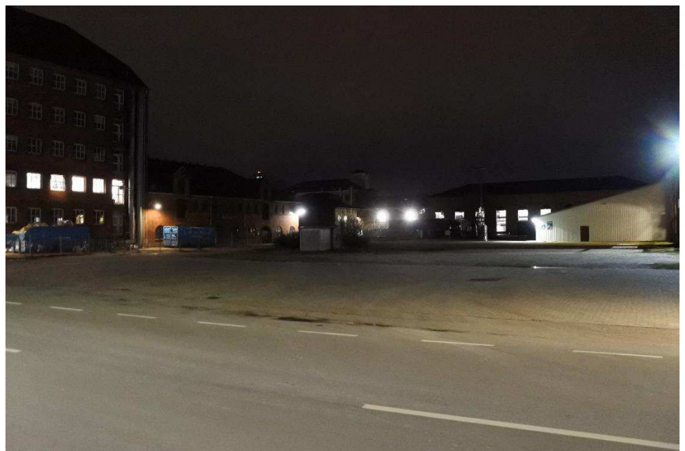
Figur 12-3 Belysning på eksisterende bygninger (COWI)
