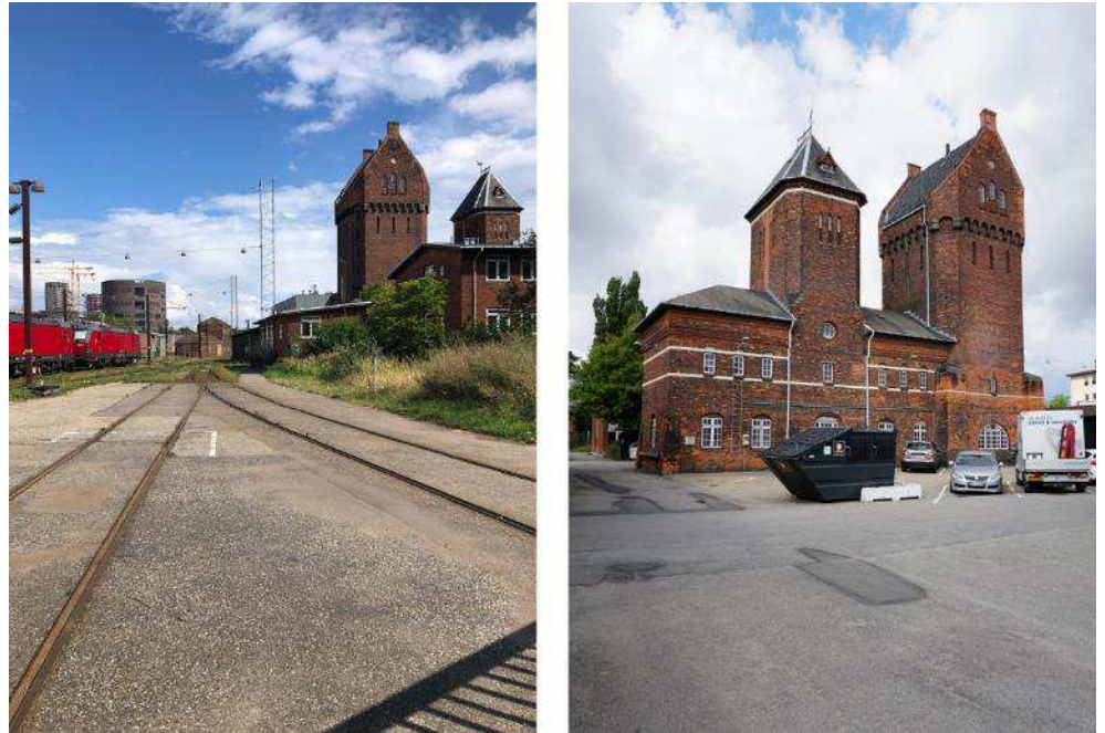
Figur 5-92 Th. Vandtårnets vestlige facade set fra Otto Busses Vej. Th. Vandtårnet set fra øst. Foto Cobe.
