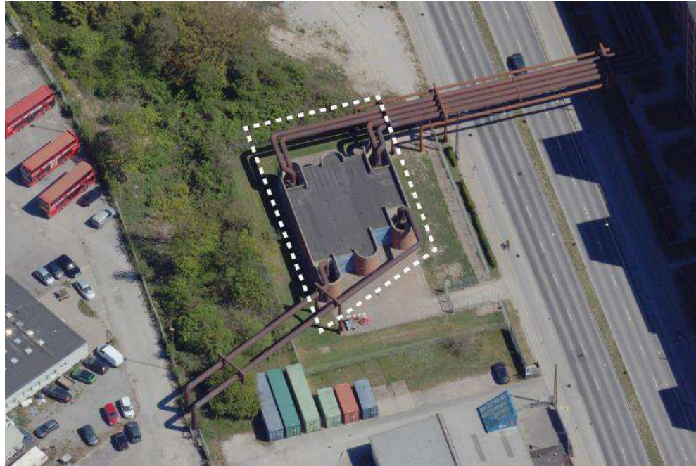
Figur 6-3 Teknisk anlæg ved Vasbygade. Foto COWI.
