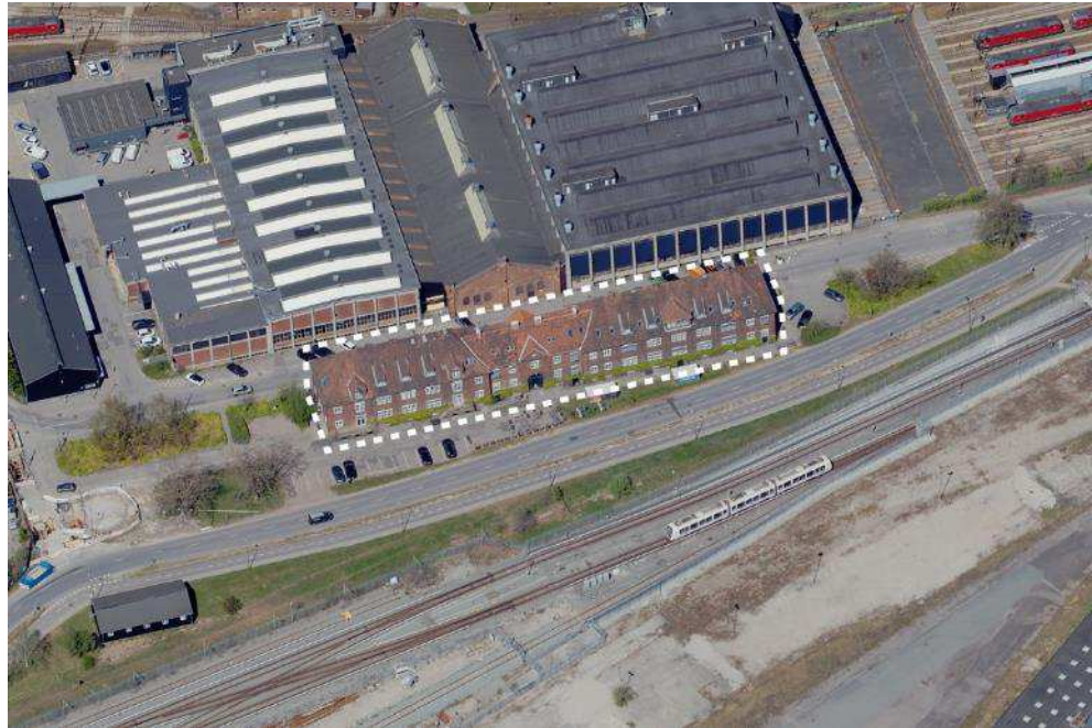
Figur 5-125 Kontor- og administrationsbygningen ses i midten af billedet og er markeret med en stiplede linje. Illustration COWI.
