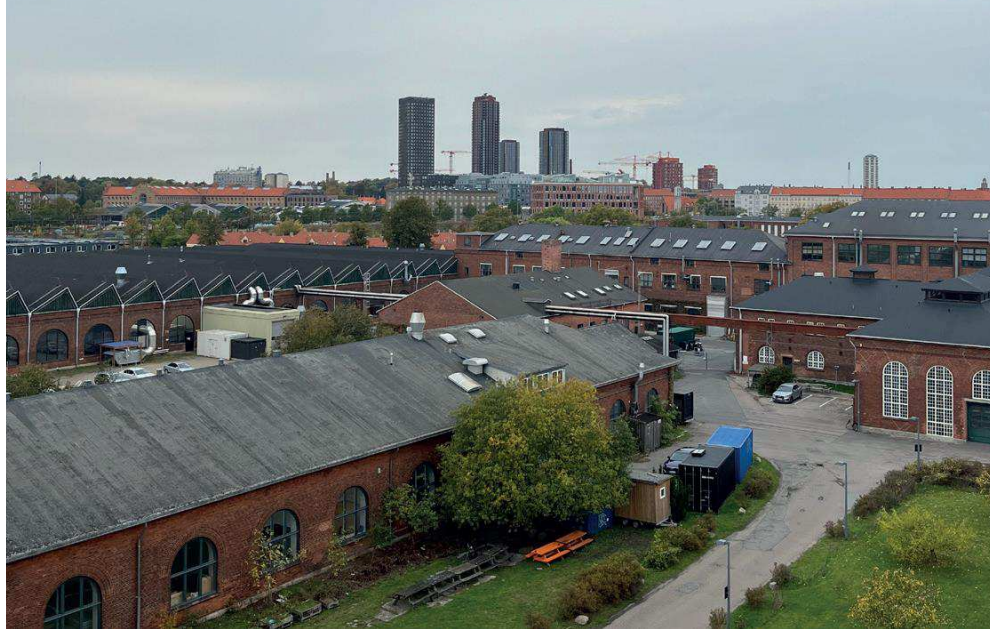
Figur 4-4 Eksisterende forhold, udsigt fra Hovedlageret mod Vognværkstedet (Foto: Cobe)
