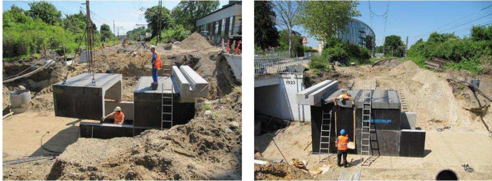
Figur 4-27 Eksempel på præfabrikerede elementer ved bro ved Gl. Bagsværdvej
