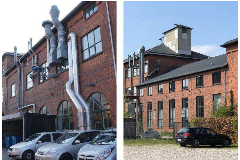
Figur 5-42 Tv. Kølerværkstedets nordfacade. Th. Kølerværkstedets sammenbygning med Nyt Elektrisk-værksted set fra syd. Foto Cobe 2023.
