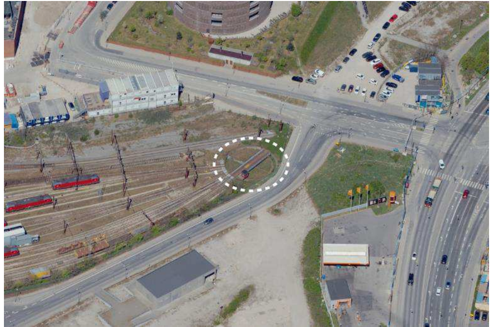
Figur 6-13 Drejeskiveanlæg, bro, førerhus og spor ses i midten af billedet og er markeret med en stiplede linje. Illustration COWI.
