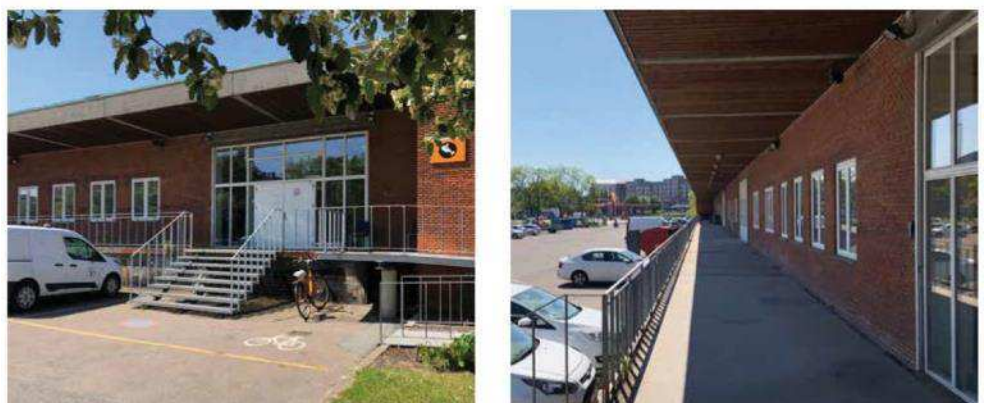
Figur 5-130 Toldkammerets facader er i røde flensborgsten. Fotos Cobe.
