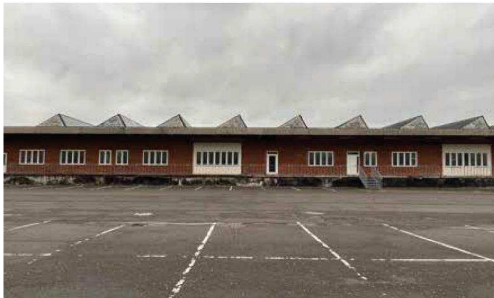
Figur 5-131 Toldkammeret set fra sydøst. Foto Cobe.
