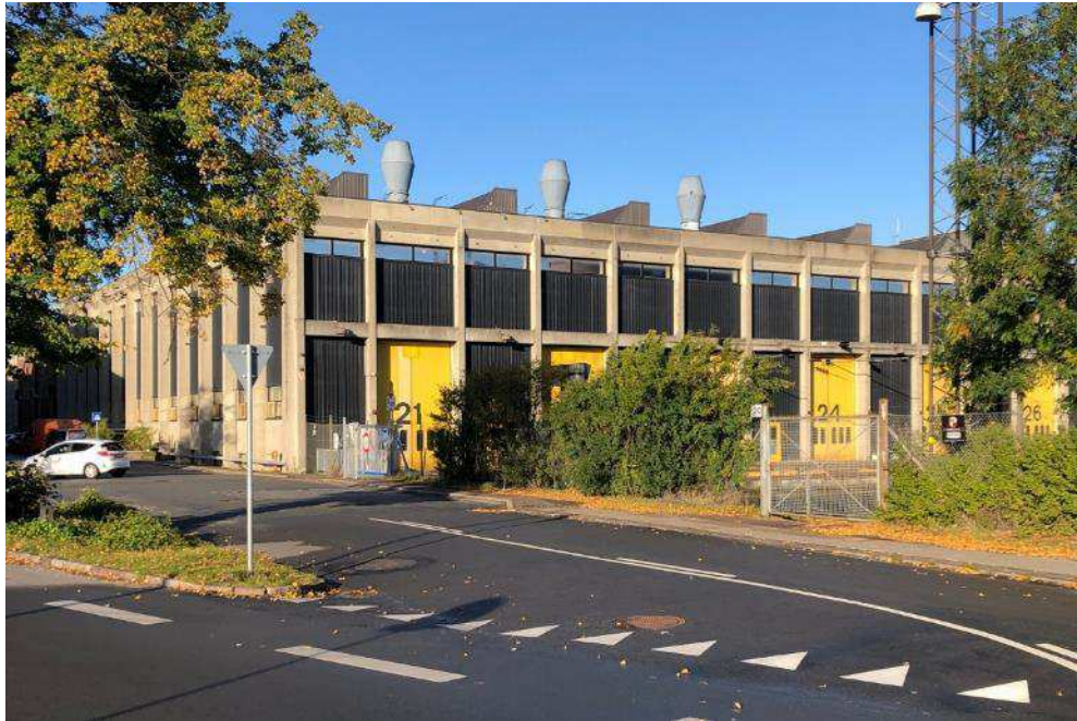
Figur 5-119 Ny eftersynshal set fra øst. Foto Cobe.
