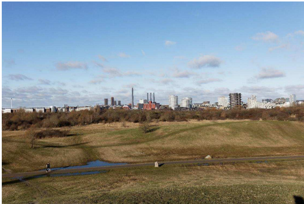
Figur 7-11 Punkt 3 – Bjerget på Amager Fælled – eksisterende forhold
