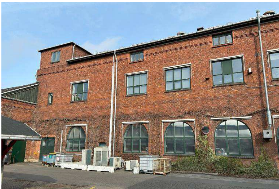
Figur 5-35 El-og sadelmagerværkstedets vestlige del af sydfacaden. Foto COWI 2024.
