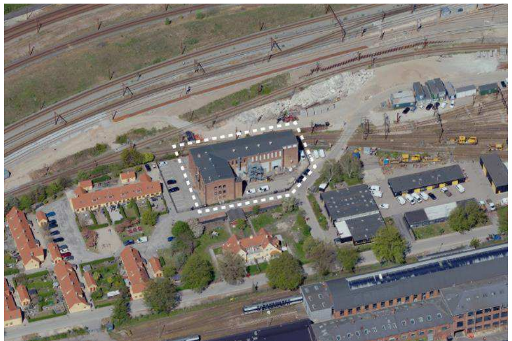
Figur 5-15 Omformerstationen set fra nord og er markeret med en stiplede linje. Illustration COWI 2024.
