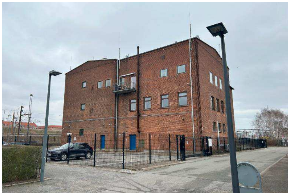
Figur 5-17 Omformerstationen set fra vest. Foto COWI 2024.
