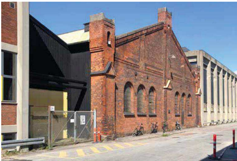
Figur 5-111 Skydebrohallens sydlige facade set fra Otto Busses Vej. Foto Cobe.
