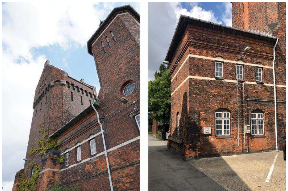
Figur 5-93 Th. Del af Vandtårnets facade set fra vest. Tv. Den sydlige del af Vandtårnet. Foto Cobe.
