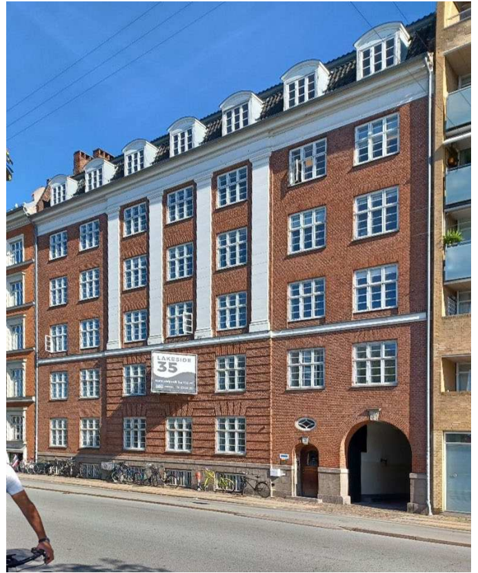
Facade mod Nørre Søgade.
