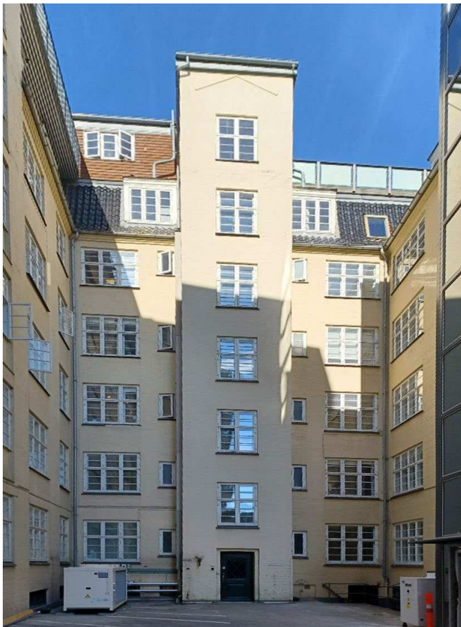
Mellemhusets facade set fra gårdrummet.
