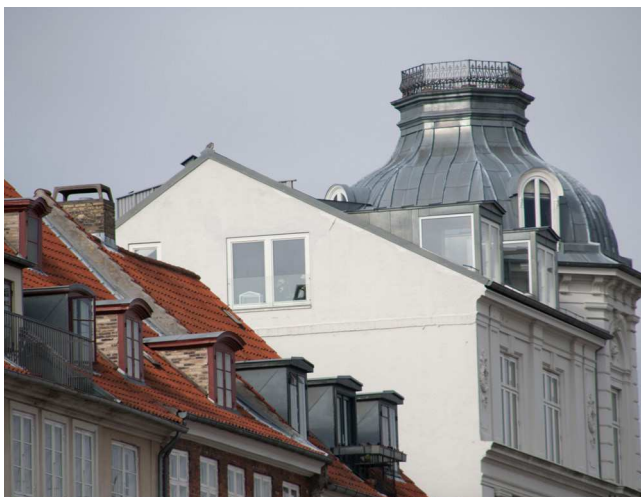
Foto 2. Smukt istandsat tårn med blødt formet tag. På de forreste tage er eksempler på nye kvistaltaner.
