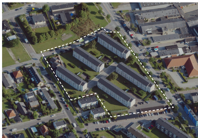
Luftfoto af Fortvænget. Bygninger omfattet af helhedsplanen er markeret med hvid stiplede linje.
