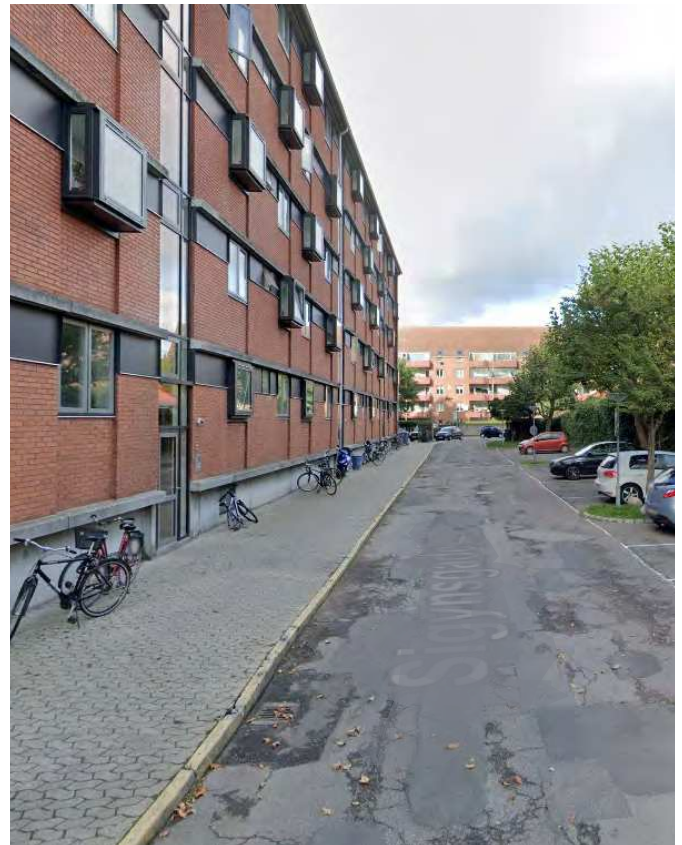
Vognvænget set fra Sigynsgade stikvej
