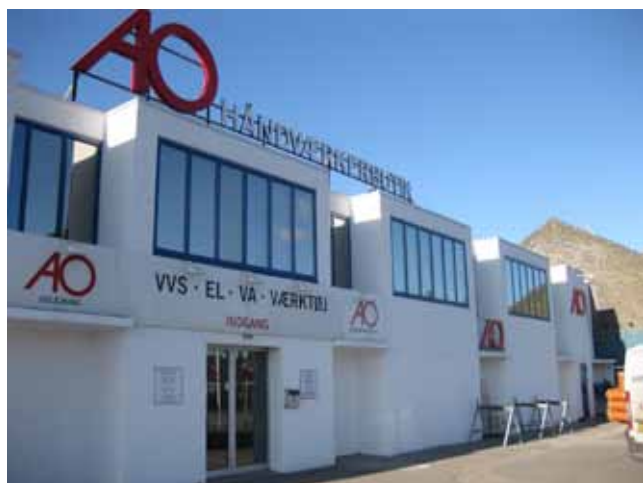
Byggeriet er inspireret af Den Hvide Kødbys arkitektursprog.
