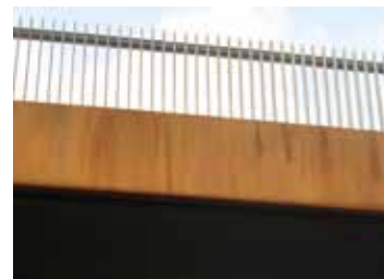
Referencefoto. Langeliniebroen beklædt med rustbrunt cortenstål.
