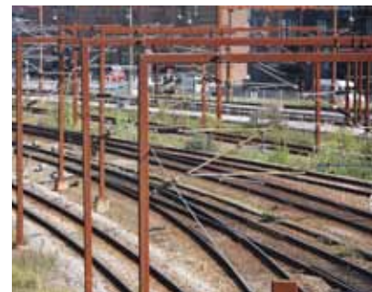
Referencefoto. Rustbrune stålmaster på baneterrænet.
