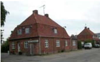
De to bevaringsværdige bygninger.
