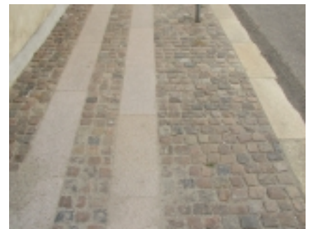
Fortov i Nicolai Eigtveds Gade: Bodurbånd og chaussesten i skandinavisk granit og fortovskant i kinesisk gul sten
