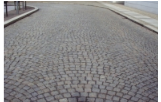
Kørebanelægning i bueforbandt, med kinesisk gul sten, udføres frem til Vej & Parks anlægsgrænse i Nicolai Eigtveds Gade.
