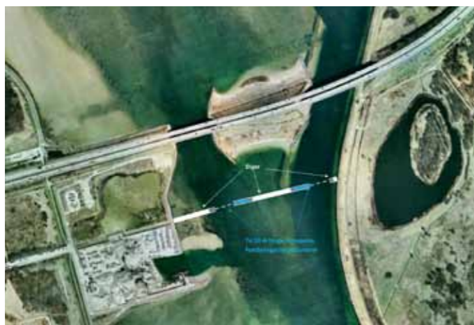
Figur 7: Etablering af sikringsanlæg syd for Kalveboderne.
