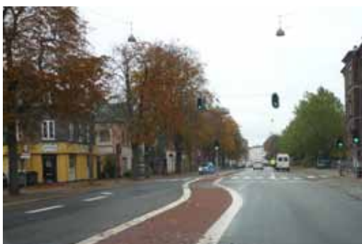
På Øster Farimagsgades Skole har vi farvet "midterhellen" ud for skolen rød og ændret signalanlægget til rødhvileanlæg, dvs. at der som udgangspunkt er rødt for bilister. Signalet skifter, når bilen kører frem med lav hastighed.
