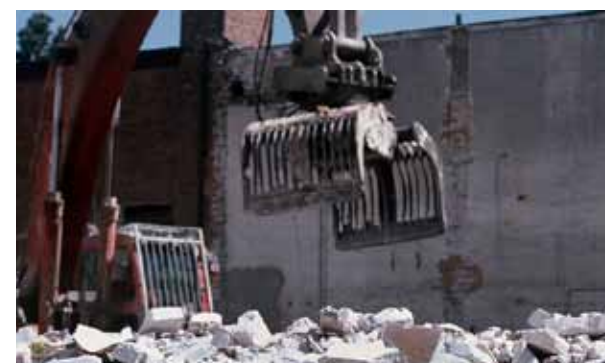
NEDRIVNING AF BYGNING
