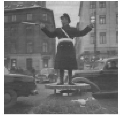
Sankt Hans Torv før renovering
