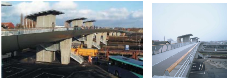
Figur 7.3. Eksempel på stibro over baneterrænet i Næstved Station
