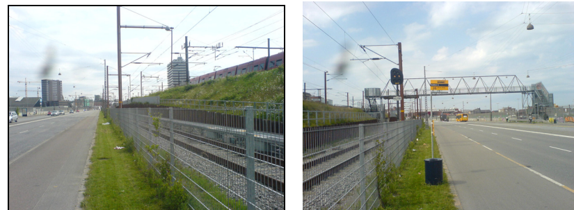
Figur 5.3. S-banen mellem Østerport og Svanemøllen Station udgør i dag en markant barriere med kun få krydsningspunkter fodgængerbroen ved Nordre Frihavns-gade.
