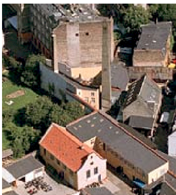
Gavlen på baghuset Vesterbrogade 107E, hvor der kan ske påbygning i 10 etager. Baghuset med det røde tag forudsættes også bevaret.
