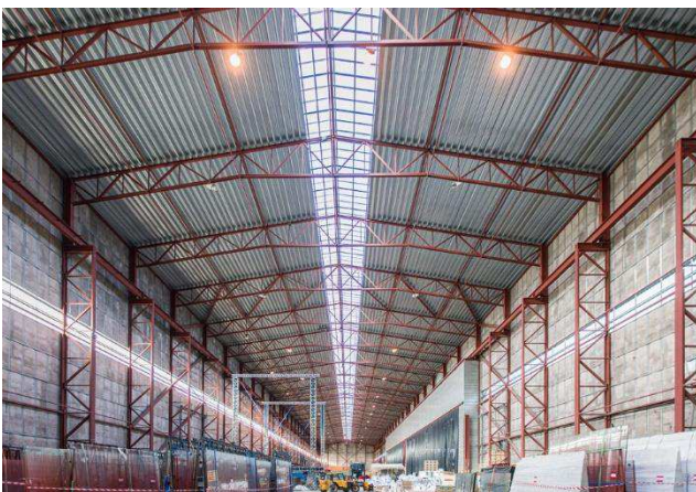
1.5 Eksisterende stålstruktur og ovenlys i Armeringshallen.
