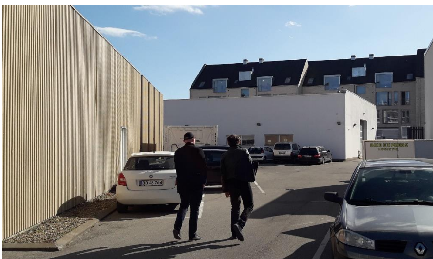
Bagsiden af erhvervsjendom ud til Frederiksborgvej der forudsættes nedrevet
