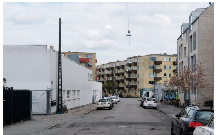
Område I - Bispevej med eksisterende bygninger til venstre i billedet, der forudsættes nedrevet, set fra vest med Frederiksborgvej i baggrunden.
