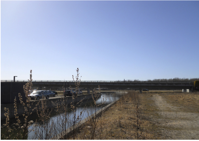
Byggegrunden støder mod syd op til den landskabelige kanal og mod vest til Metro.
