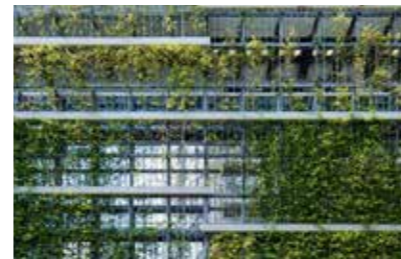
Eksempel grøn facade ved Parkeringshus.
