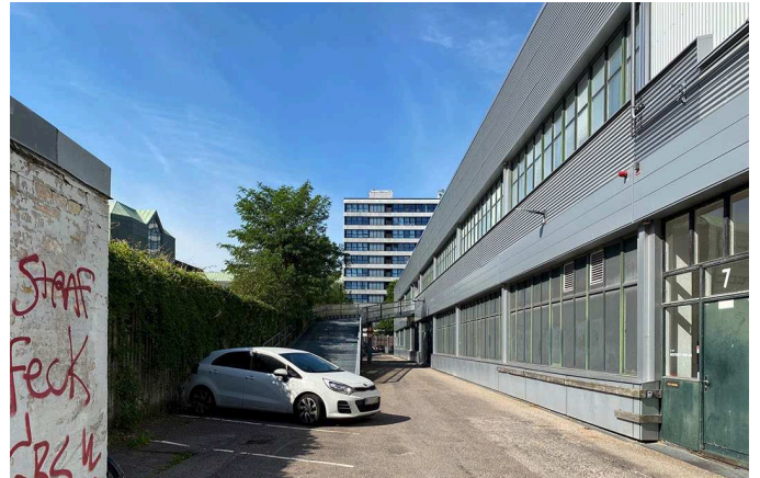
Kig ind på lokalplanområdet fra Bryggervangen langs det sydlige skel. Højhuset ses i baggrunden.
