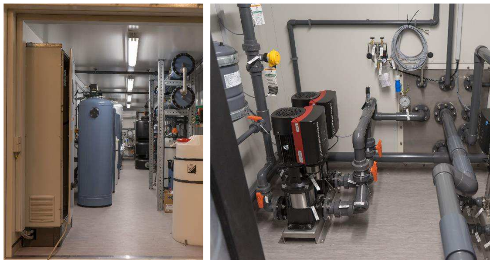
Figur 4-6 Eksempler på indretning af Silhorko vandbehandlings container.
