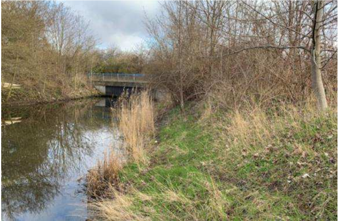
Figur 15.8: Den nordlige del af Enghave kanal, set fra syd mod nord, med overløbsbygværket i baggrunden. Foto: NIRAS, d. 13.04.2021.
