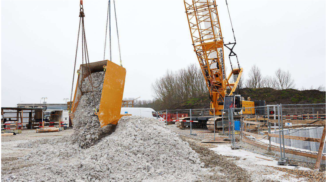
Figur 5.9 Tunnelmuck hejses op fra skakten til bortkørsel.
