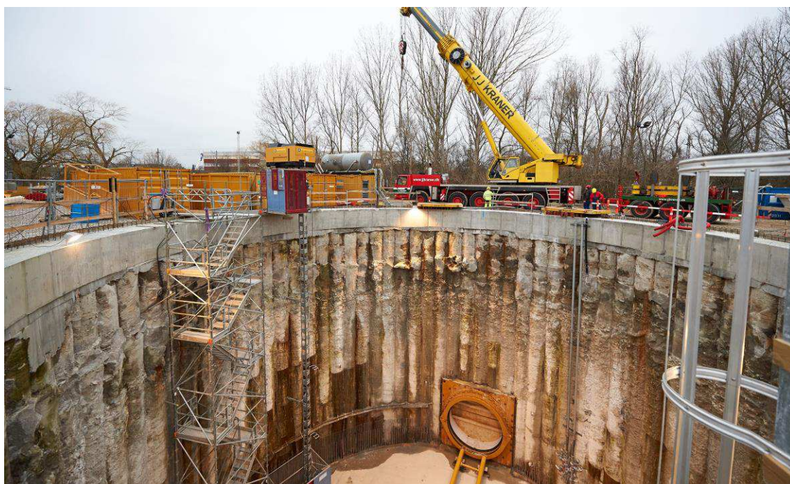
Figur 5.6 Skakt udført med sekantpælevæg.
