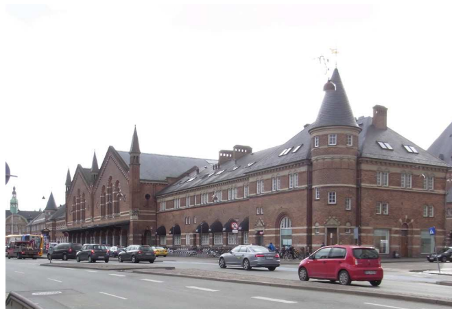
Københavns Hovedbanegård blev opført i 1911 (ark. Heinrich Wenck). Den er karakteriseret ved de store røde teglstensfacader og bukonstruktionerne over jernbaneperronerne.
