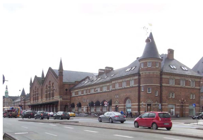
Københavns Hovedbanegård blev opført i 1911 (ark. Heinrich Wenck). Den er karakteriseret ved de store røde teglstensfacader og bukonstruktionerne over jernbaneperronerne.
