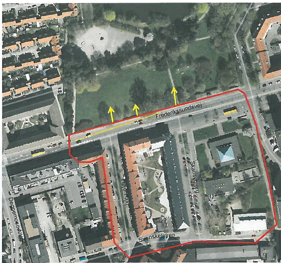
Figur 12. Opland til Brønshøjparken med flere udledningspunkter
