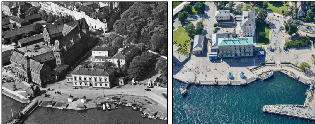
Figur 6.2.2.3 Nordre Toldbod med Frilagerbygning (tv) og i dag set fra luften (th) (Skråfotos, SDFE, 2021)
