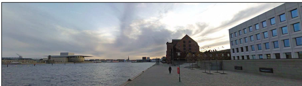
Figur 6.6.1.2 Foto af havnepromenaden fra Esplanaden 50 med Inderhavnen (tv.) og Vestindisk Pakhus (mf.). Byggeriet der nedrives på Amaliegade 44 ses mellem pakhuset og Mærskes hovedsæde (th.) (Kilde: Google Street View).
