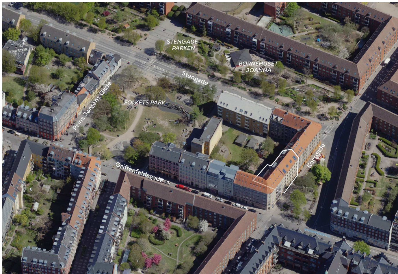
Området set mod øst. Lokalplanområdet er indtegnet med hvid linje, og de vigtigste gader og pladser er navngivet. Luftfoto: SDFI, 2023.
