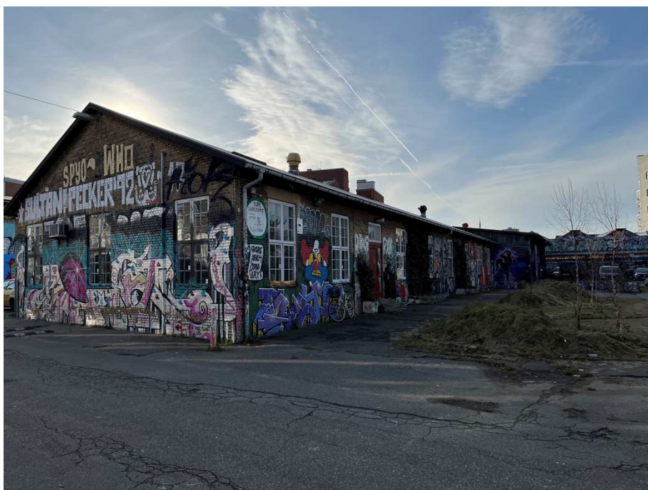
Bygning III – Den nordligst placerede af de oprindelige tværliggende bygninger.
