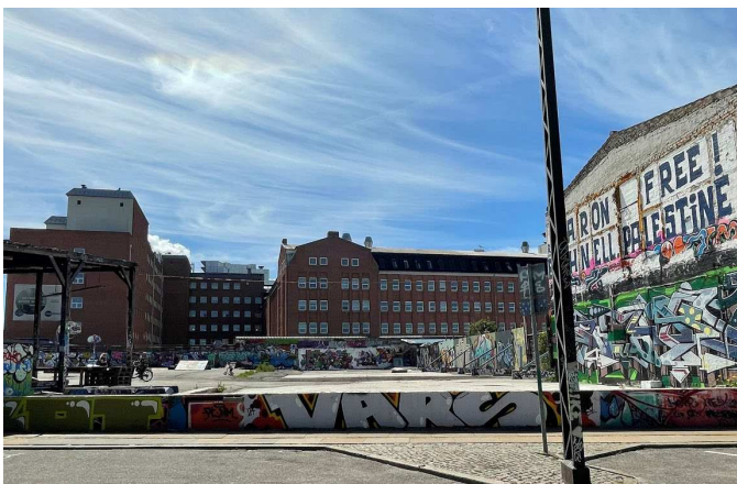
Billede af området set fra den sydlige del af Ragnhildgade, hvor der kan etableres en ny overkørsel ind til KTK-grunden. I baggrunden ses nabogrundens industribygninger.
