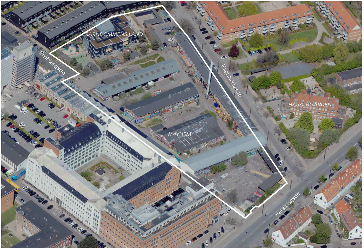
Området set mod nord. Lokalplanområdet er indtegnet med hvid linje, og de vigtigste gader, pladser og bygninger er navngivet. De to sydlige bygninger er nedrevet. Luftfoto: SDFI, 2023.
