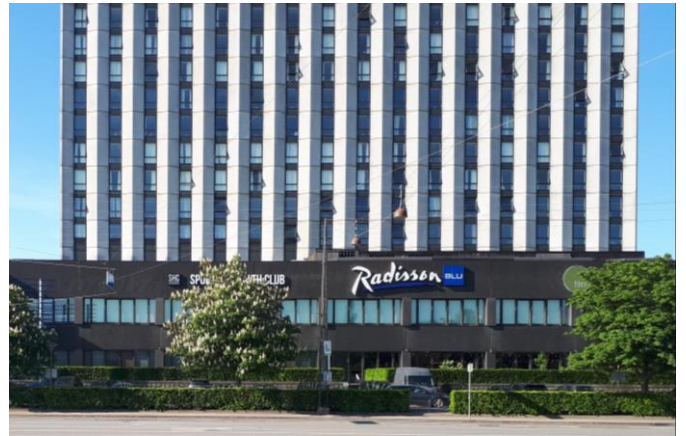
Lokalplanområdet set fra Amager Boulevard
